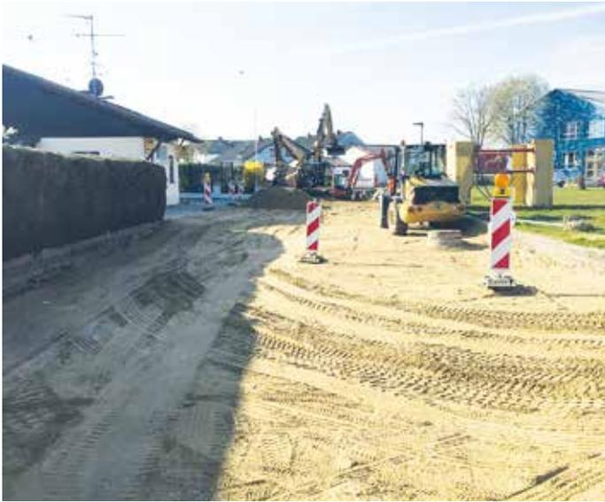
Die fast 500.000 Euro teure Generalsanierung der Schulstraße ist gut im Plan. Die Erneuerung der Wasserleitung ist bereits vollständig abgeschlossen. Derzeit wird der Aufbau des Straßenkoffers eingebracht. Nach Aussage der ausführenden Firma kann für Mitte Mai mit den Teerarbeiten gerechnet werden.
