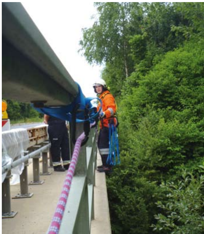
Fuchs Markus FFW Kirchdorf und Bauhofmitarbeiter
