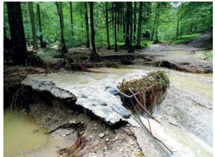
Der Hitzenauer Bach hat eine Straße aufgerissen und unterspült.
