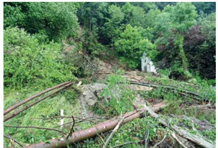
Der Hang neben der Eckener Kapelle (Mitte rechts) ist abgerutscht.
