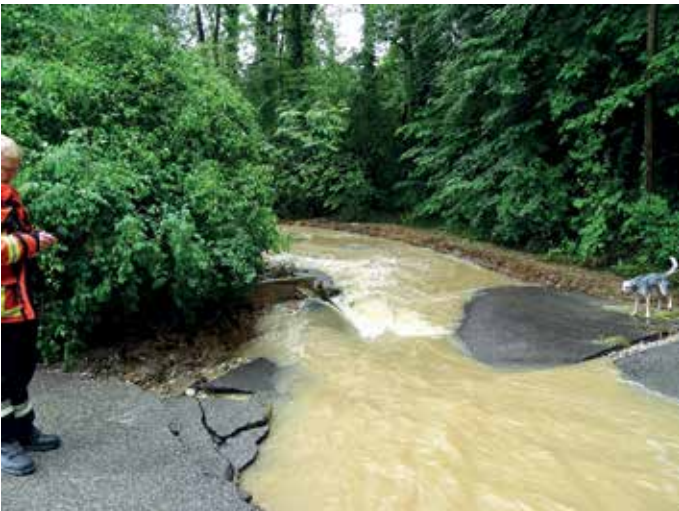
Der Palmbach frisst sich durch das Gelände.
