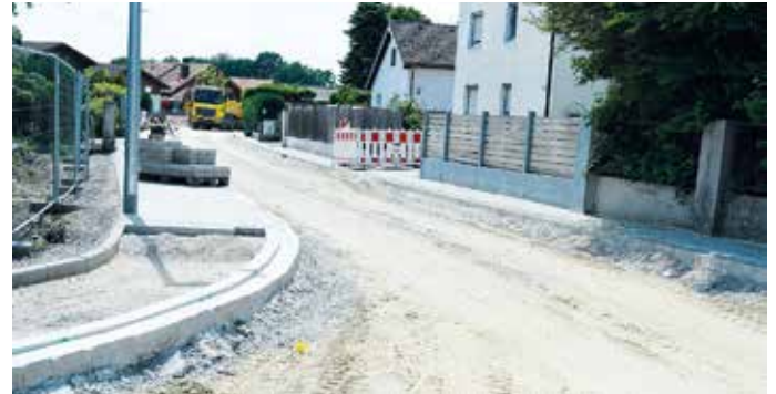
Der Straßenbau nimmt bereits sichtbare Formen an
